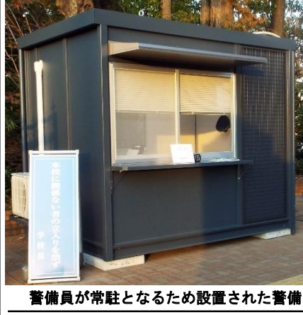
警備員が常駐となるため設置された警備員小屋
