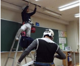
LEDの取り付け作業をする業者の方々
