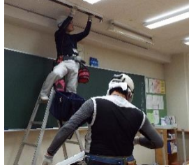
LEDの取り付け作業をする業者の方々
