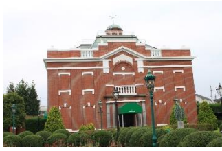
長い間小平を見守る赤煉瓦洋館
